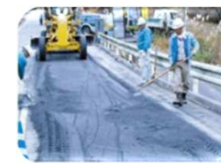
焙焼炉路盤材再資源化
