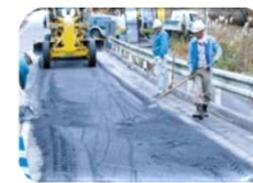
焙焼炉路盤材再資源化
